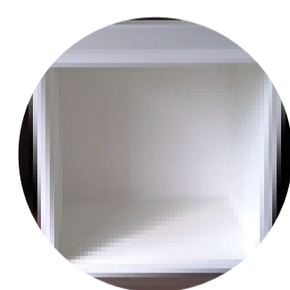
Mdf revestido com fo'rmica branca: Compõe os nichos nas paredes, os rabos contidos na vitrine e os tablados da mesma.
